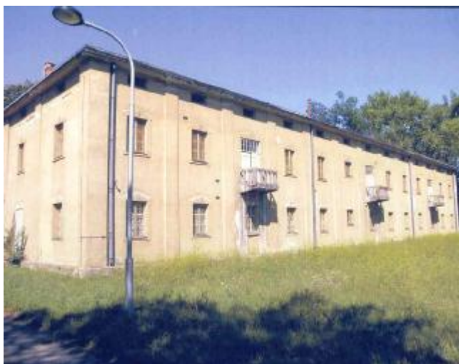
Зграда у кампусу Универзитета која је додељена Архитектонско- грађевинском факултету, на којој се очекује адаптација и реконструкција.
