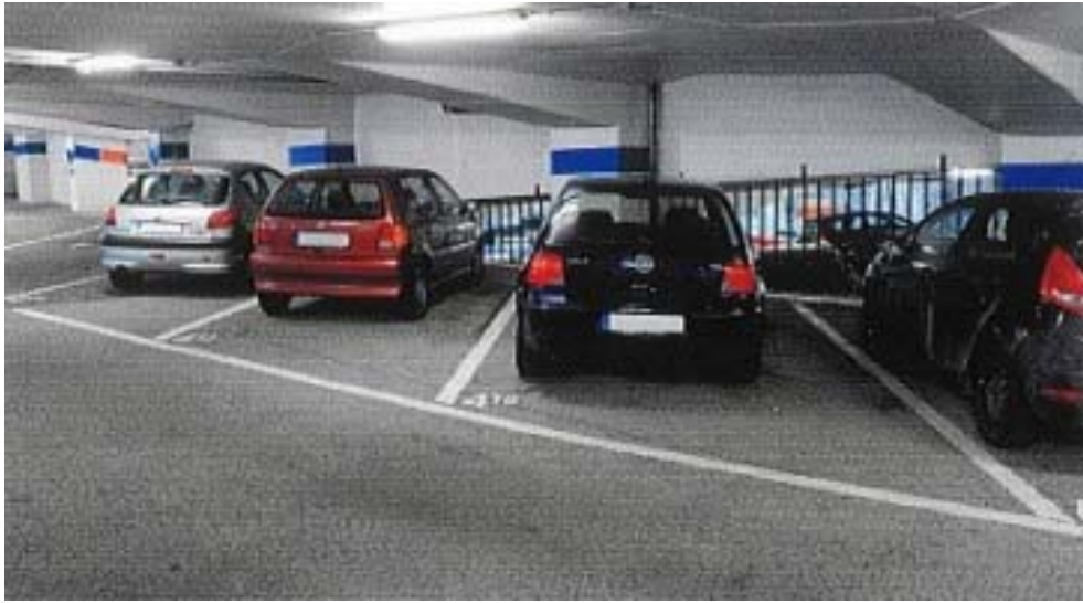
возна линија и паркинг мјеста означена хладном пластичном апликацијом на свијетлом асвалту ( Wiesbaden, Parkhaus Theater )
