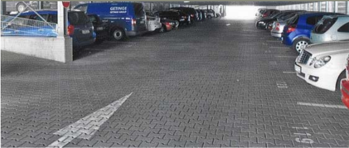
поплочана паркинг површина приземног нивоа ( System Goldbeck )
