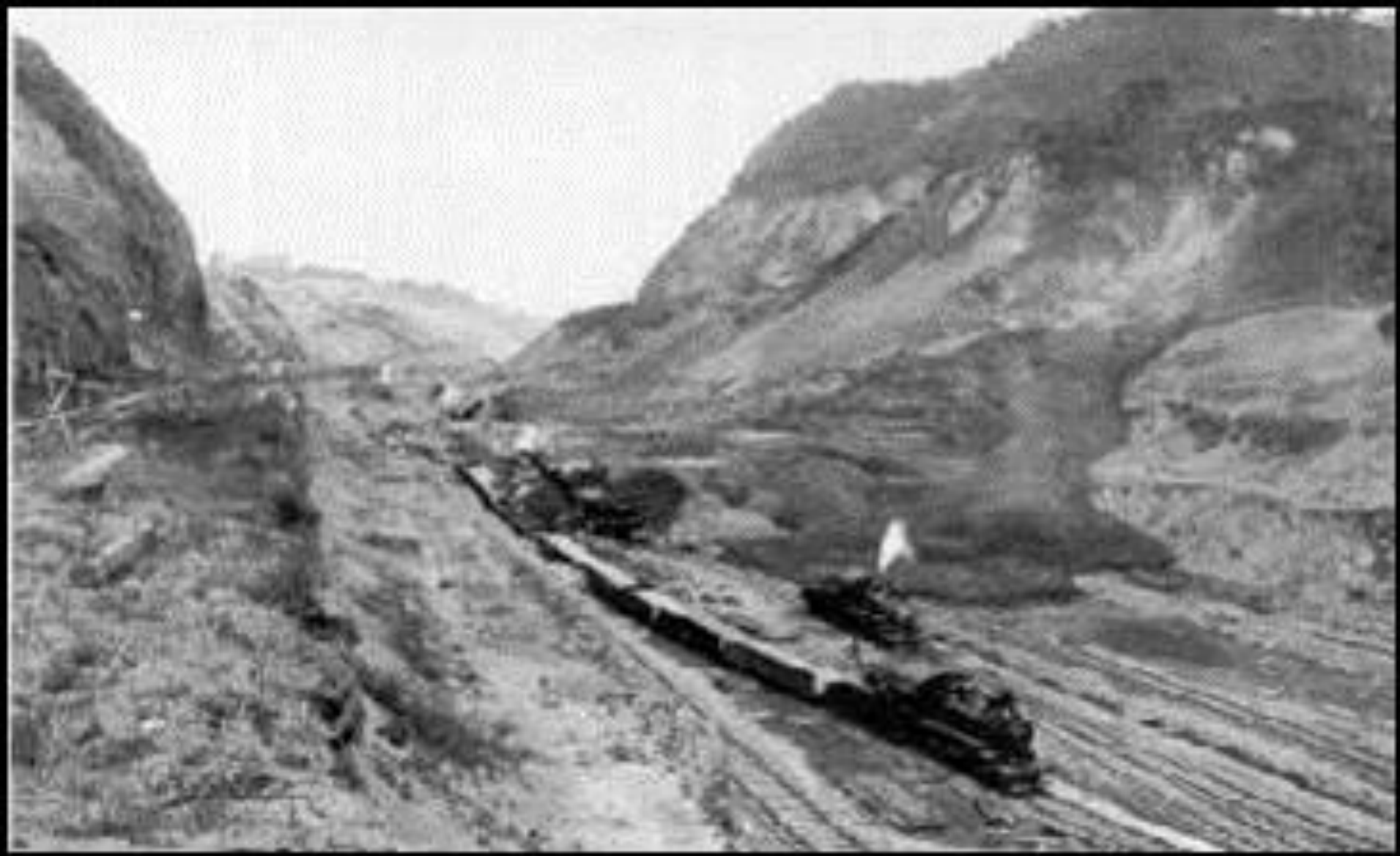
Panamski kanal, 1913. god. (13 miliona kubika kliznulo je pri iskopu bokova kanala)
