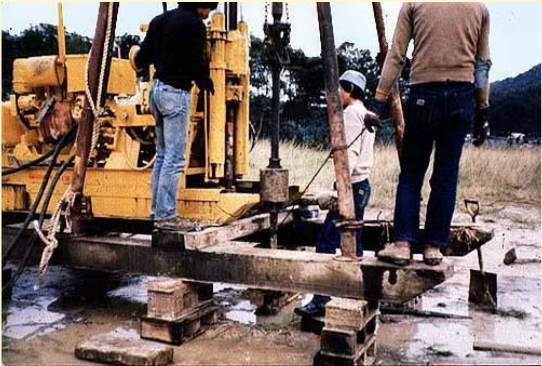
SPT in-situ (udarac bata o nakovanj)
